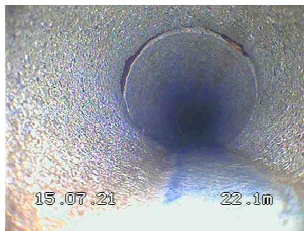
2-1-17A, 00:05:57, 22.10m Assemblage déplacé de 8 h. à 3 h.
