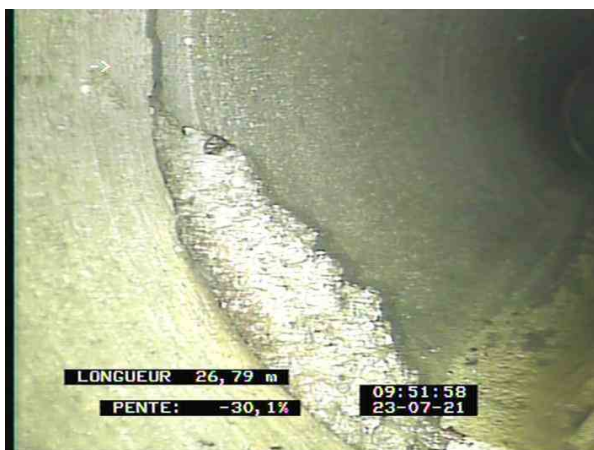
4-1-14A, 00:15:02, 26.79m Dépôts adhérents de 6 h. à 9 h. / béton
