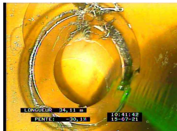
1-1-11A, 00:11:12, 34.11m Ensemble complexe de racines de 12 h. à 12 h. / Racine prise dans l'emboîtement du tuyau
