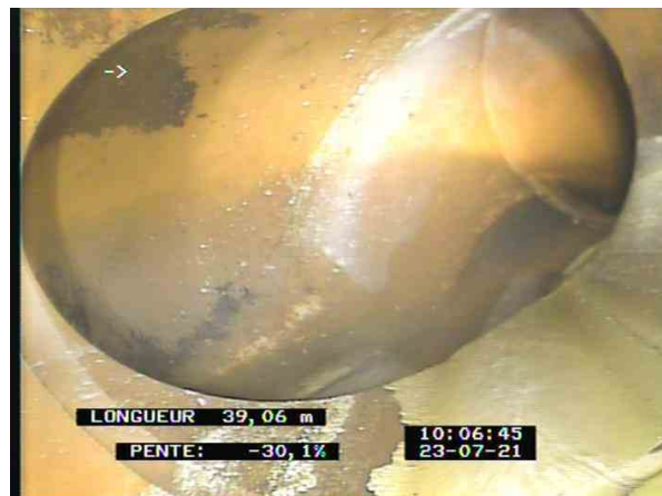
4-1-25A, 00:25:57, 39.60m Raccordement avec pièce préfabriquée à 12 h. / Arrivé dans un collecteur
