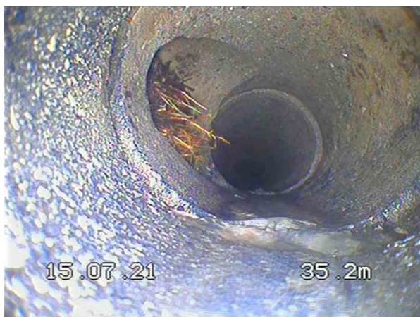
2-1-26A, 00:09:43, 35.20m Raccordement avec pièce préfabriquée à 9 h. / Impossible de prendre le pickage avec la buse à chaîne
