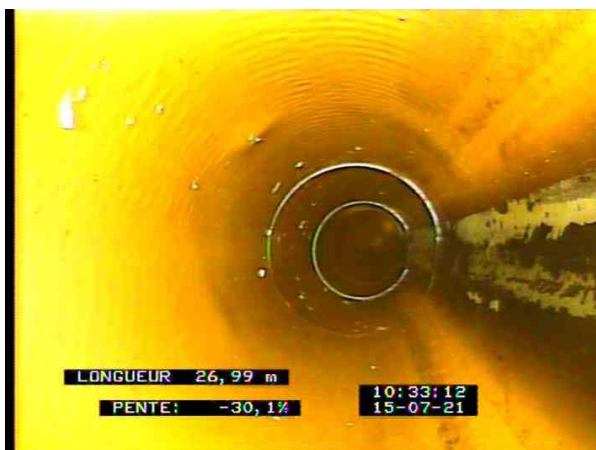
1-1-6A, 00:06:52, 26.99m Dégradation de surface, autre à 1 h. / Point
