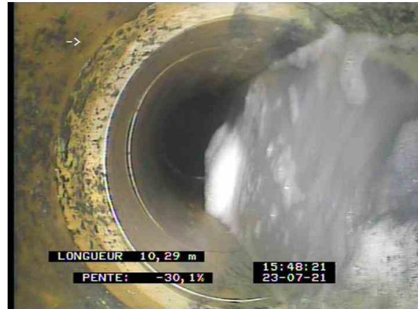
6-1-9A, 00:05:34, 10.29m Niveau d'eau, effluent trouble, hauteur: 0%, Début
