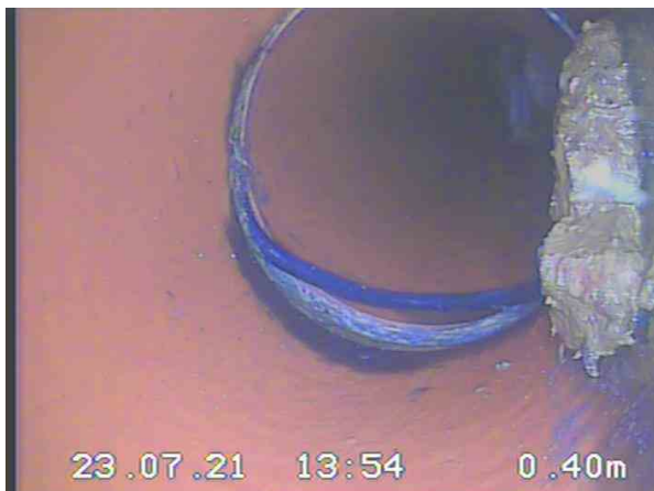
3-1-4A, 00:01:17, 0.40m Joint d'étanchéité apparent de 6 h. à 11 h.
