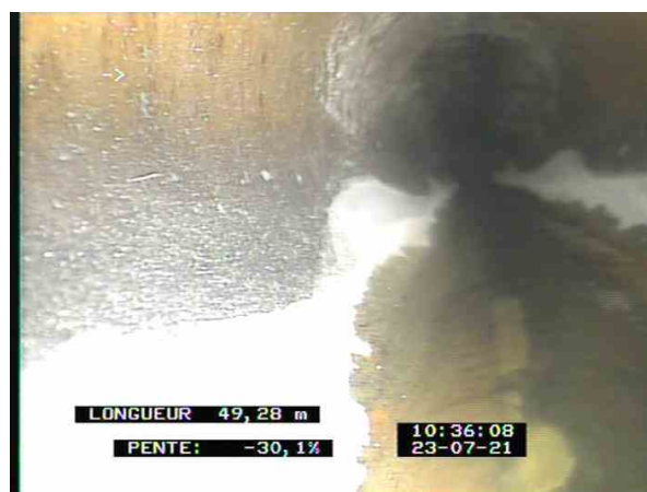
4-1-31A, 00:37:00, 49.28m Inspection abandonnée / Impossible de poursuivre l'investigation, 49,28 mètres de caméra + les coudes le robot n'avance plus
