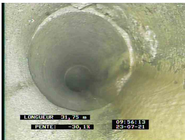
4-1-18A, 00:18:06, 31.75m Assemblage déplacé de 12 h. à 12 h.
