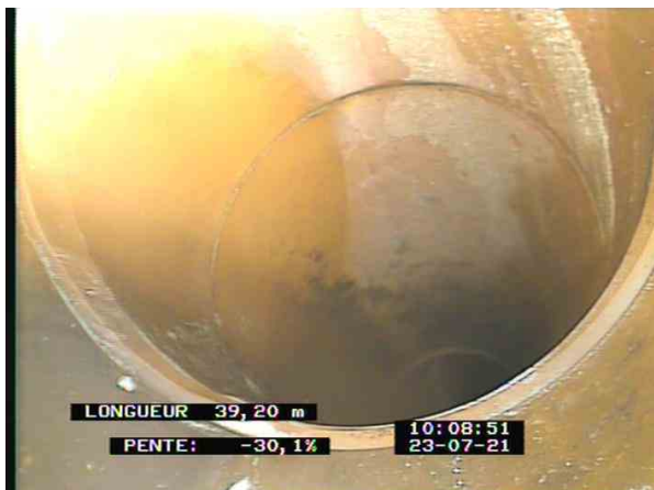
4-1-24A, 00:27:02, 39.20m Courbure vers la droite et vers le bas
