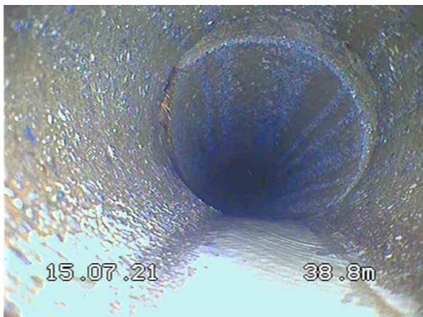
2-1-28A, 00:11:29, 38.80m Assemblage déplacé de 12 h. à 12 h.
