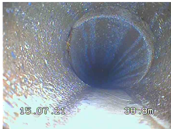
2-1-29A, 00:11:32, 38.80m Assemblage déboîté de 12 h. à 12 h., Fin
