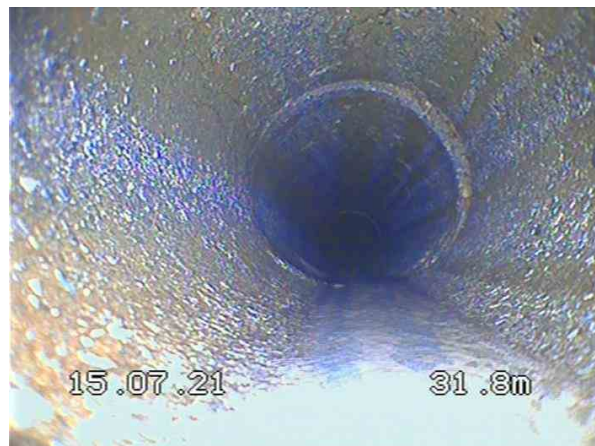
2-1-25A, 00:09:08, 31.80m Assemblage déplacé de 10 h. à 5 h.
