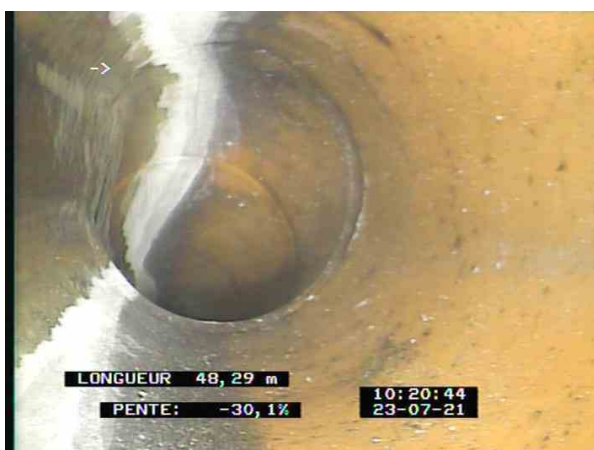
4-1-30A, 00:33:50, 48.29m Courbure vers la droite
