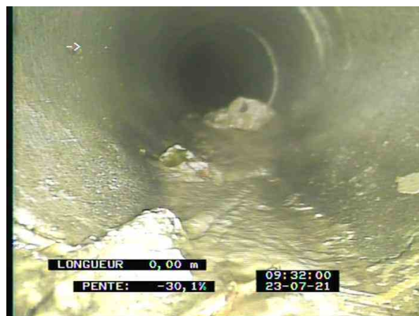
4-1-3A, 00:00:08, 0.00m Dépôts durs, hauteur: 0% de 5 h. à 7 h. / Cailloux
