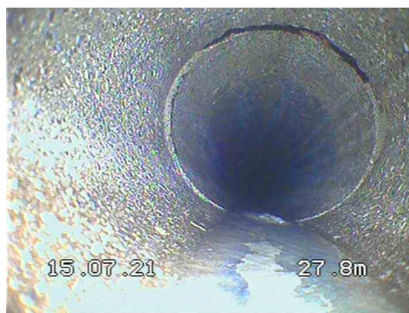
2-1-23A, 00:07:40, 27.80m Assemblage déplacé de 12 h. à 12 h.
