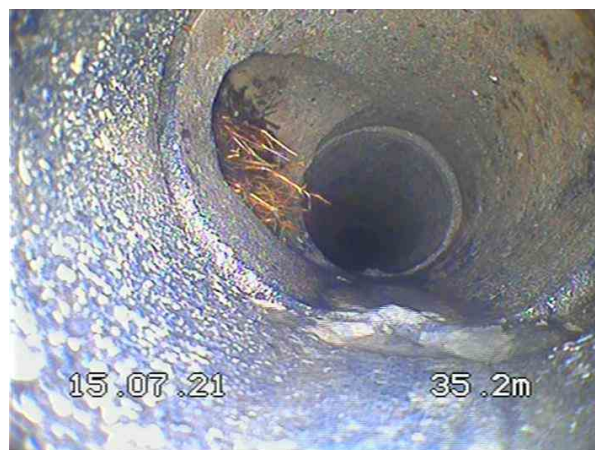
2-1-27A, 00:09:49, 35.20m Ensemble complexe de racines à 9 h. / Ensemble complexe de racines dans le raccordement latéral
