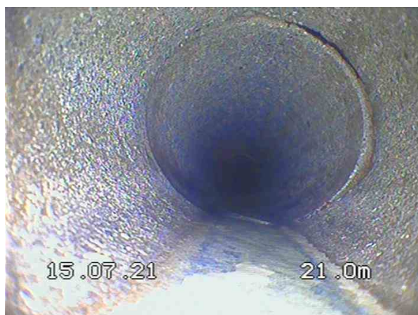
2-1-16A, 00:05:42, 21.00m Assemblage déplacé de 12 h. à 12 h.
