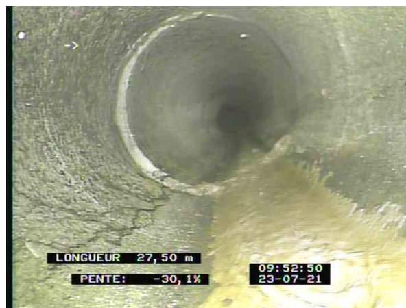
4-1-15A, 00:15:37, 27.50m Assemblage déplacé de 7 h. à 1 h.
