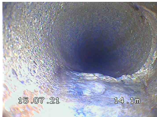
2-1-13A, 00:04:17, 14.00m Dépôts durs, hauteur: 0% de 4 h. à 7 h. / Calcaire
