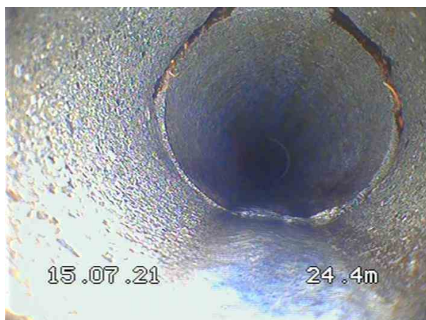
2-1-20A, 00:06:48, 24.40m Assemblage déplacé de 12 h. à 12 h.
