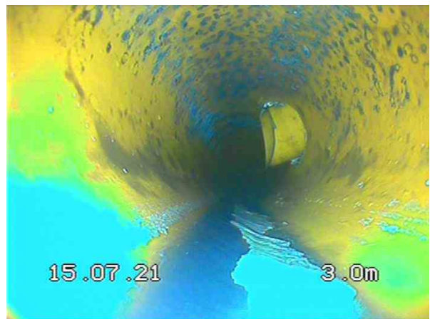
2-1-3A, 00:00:26, 3.00m Branchement pénétrant à 3 h.
