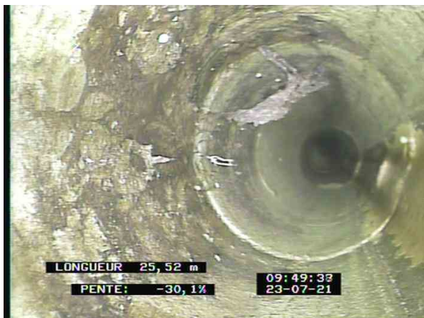
4-1-12A, 00:13:29, 25.52m Dégradation de surface, autre de 9 h. à 3 h.
