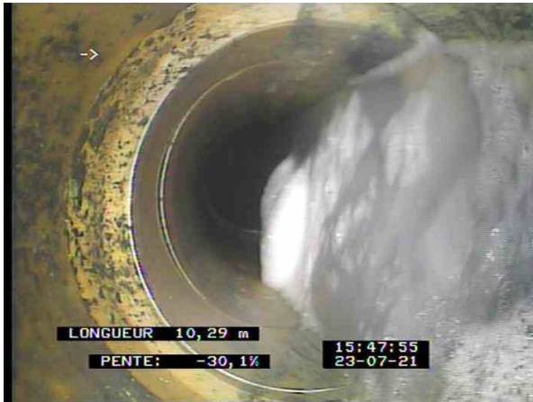
6-1-8A, 00:05:30, 10.29m Modification de la section transversale de la canalisation: circulaire
