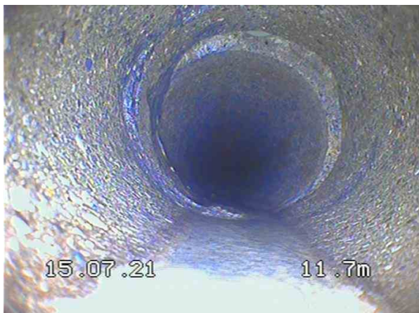
2-1-12A, 00:03:42, 11.70m Assemblage déplacé de 12 h. à 12 h.
