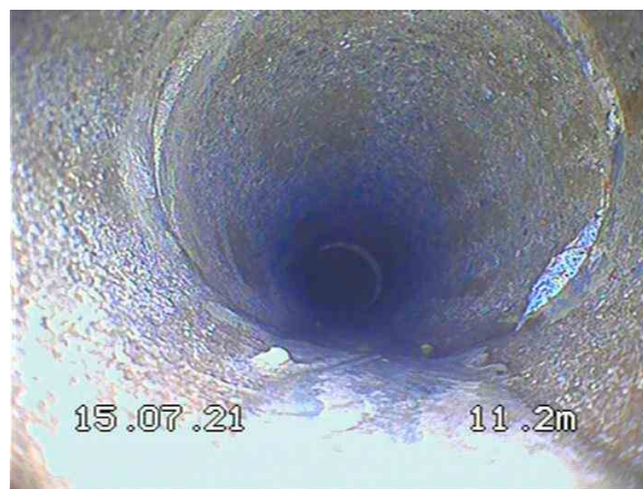
2-1-11A, 00:03:23, 11.20m Assemblage déplacé de 9 h. à 5 h.
