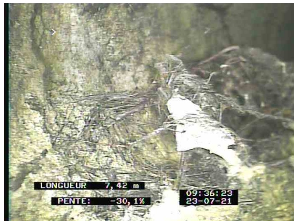
4-1-5A, 00:03:50, 7.42m Ensemble complexe de racines de 6 h. à 8 h. / Racine supprimer le 23/07/21
