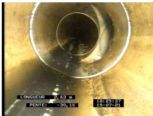
1-1-3A, 00:01:05, 2.63m Raccordement avec pièce préfabriquée à 3 h.
