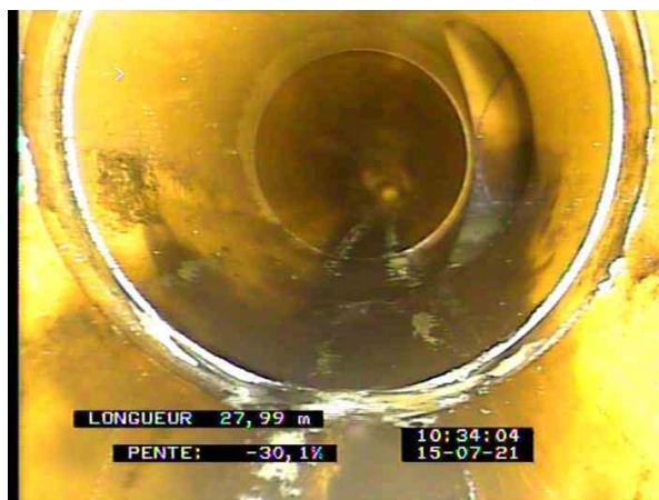
1-1-7A, 00:07:28, 27.99m Raccordement avec pièce préfabriquée à 3 h.
