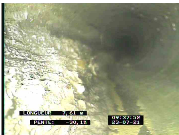
4-1-6A, 00:04:47, 7.61m Encrassement de 5 h. à 8 h. / dépôt de graisse ou calcaire / Supprimer le 23/07/21
