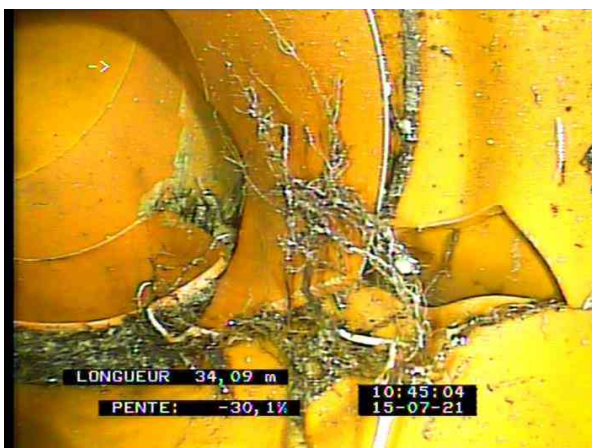
1-1-10A, 00:12:00, 34.09m Remarque générale / Enbranchement cassé avec des racines qui se sont logés dedans
