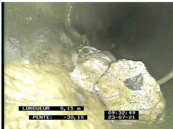
4-1-4A, 00:00:35, 0.15m Dépôts durs, hauteur: 0% de 5 h. à 7 h. / Cailloux
