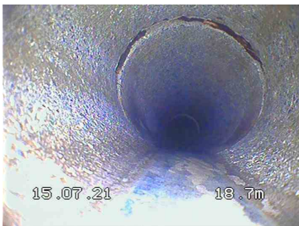
2-1-14A, 00:05:02, 18.60m Assemblage déplacé de 8 h. à 3 h.
