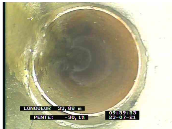
4-1-21A, 00:20:38, 33.88m Changement du matériau de la canalisation: chlorure de polyvinyle
