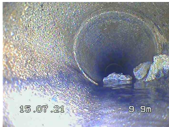
2-1-9A, 00:02:58, 9.90m Dépôts durs, hauteur: 0% de 4 h. à 7 h. / Morceau de cailloux
