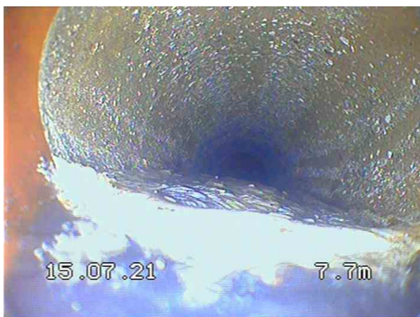
2-1-6A, 00:01:36, 7.70m Dépôts adhérents de 4 h. à 8 h. / Langue de calcaire
