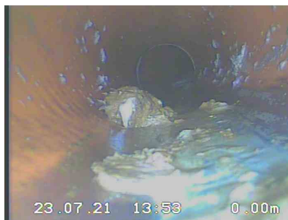
3-1-3A, 00:00:12, 0.00m Dépôts adhérents de 5 h. à 7 h. / éffluents
