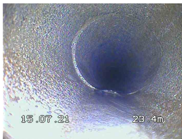
2-1-19A, 00:06:29, 23.40m Assemblage déplacé de 7 h. à 12 h.
