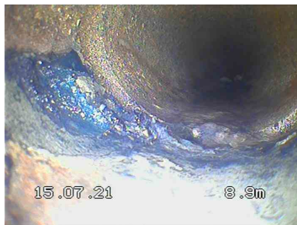
2-1-7A, 00:02:27, 8.90m Assemblage déboîté de 12 h. à 12 h., Début
