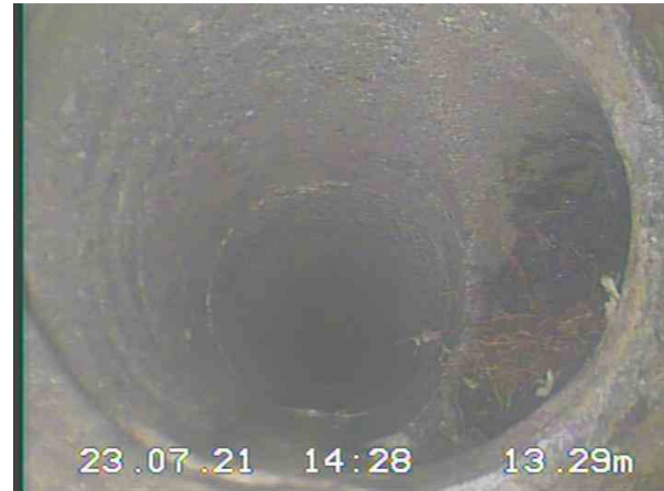
5-1-5A, 00:03:32, 13.29m Raccordement avec pièce préfabriquée à 3 h. / Impossible de prendre le pickage avec la buse à chaîne
