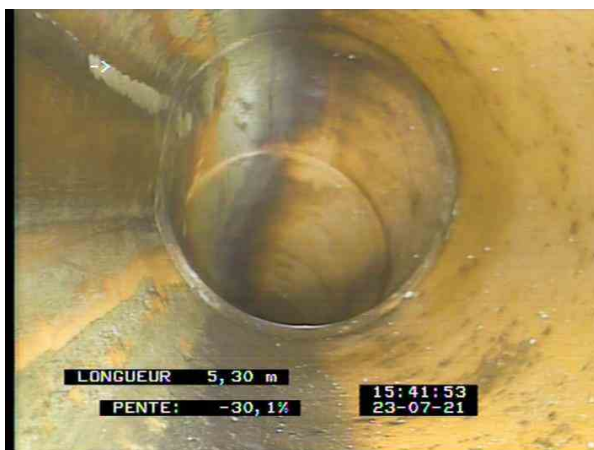
6-1-6A, 00:03:05, 5.30m Courbure vers la droite
