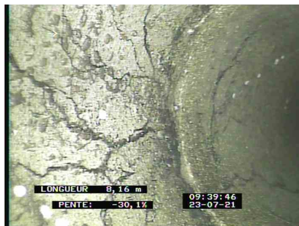
4-1-7A, 00:05:41, 8.16m Remarque générale / ensemble complexe de fissures
