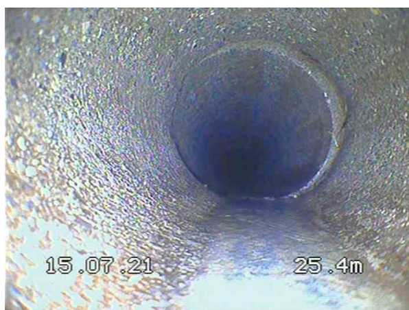
2-1-22A, 00:07:10, 25.40m Assemblage déplacé de 10 h. à 5 h.
