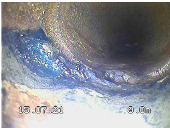
2-1-8A, 00:02:36, 9.00m Conduite poreuse de 3 h. à 9 h.
